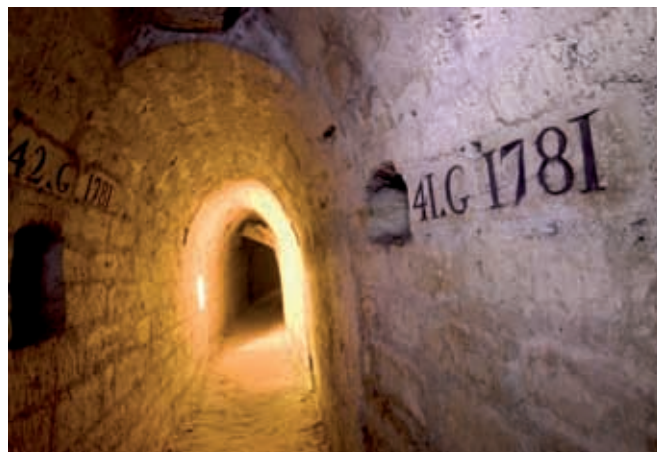
Galerie réalisée en 1781 sous l'hôpital Cochin, du temps de l'Inspectorat de Charles-Axel Guillaumot, d'où l'initiale "G" (ici les travaux numérotés 41 et 42).
