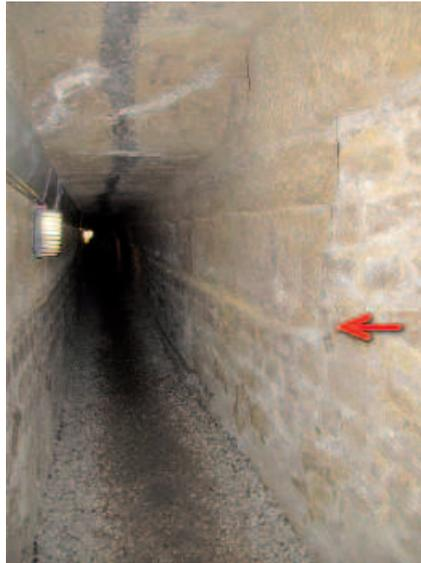
De part et d'autre de la galerie, la masse de calcaire au-dessus des murs de consolidation se trouve au niveau de l'épaulement des visiteurs.
