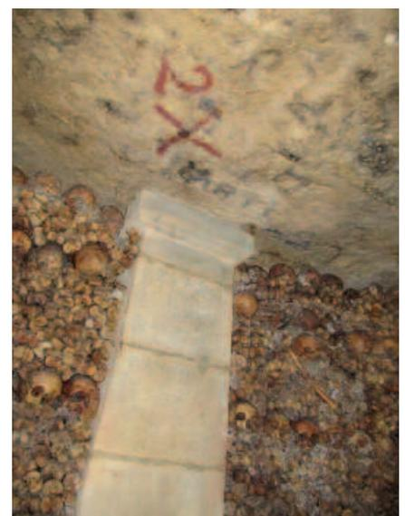
La croix en ciel numérotée deux, positionne l'emplacement du fil à plomb nécessaire dans toute cartographie pour déterminer la verticale.
