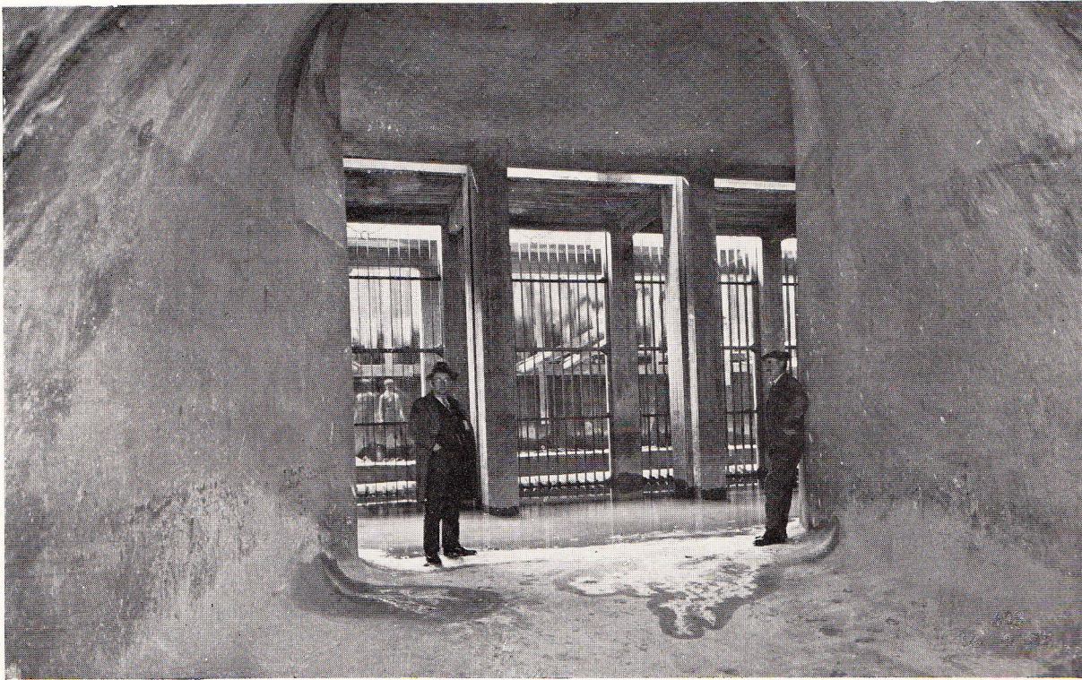
Fig. 12. — Vue intérieure de la prise d'eau en Seine montrant les grilles de protection.
