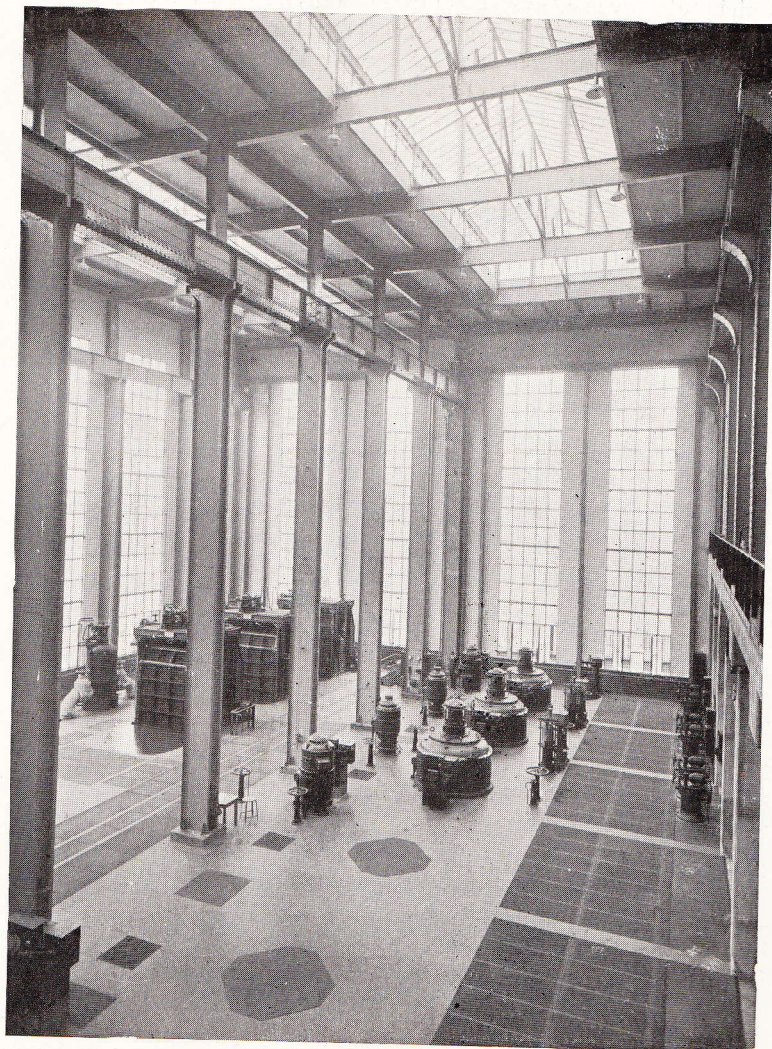
Fig. 13. — Vue de la salle de filtrage et de pompage.
